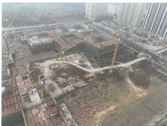
西侧在建工程
