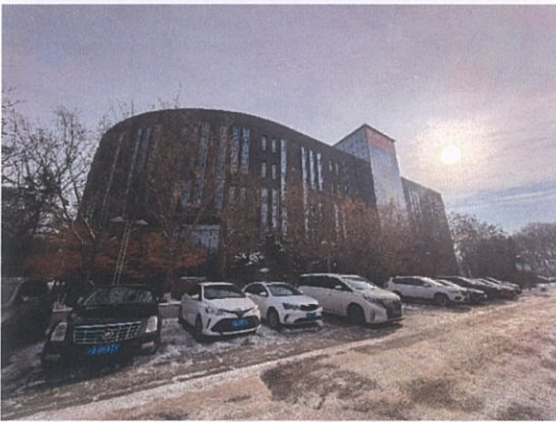
软件园一期 F8 外观
