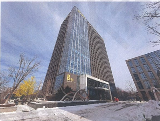
软件园一期 B20 外观
