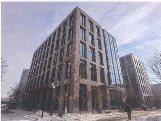
软件园一期 B19 外观
