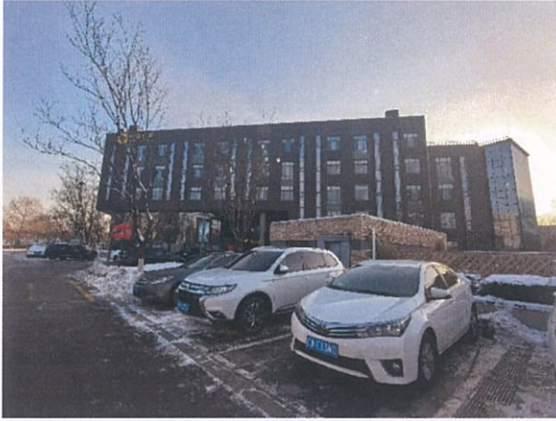
软件园一期 F7 外观
