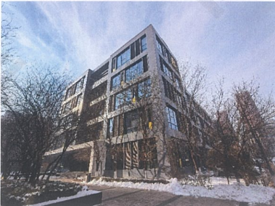
软件园一期 B05 外观
