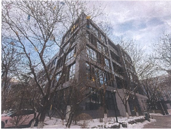
软件园一期 B06 外观
