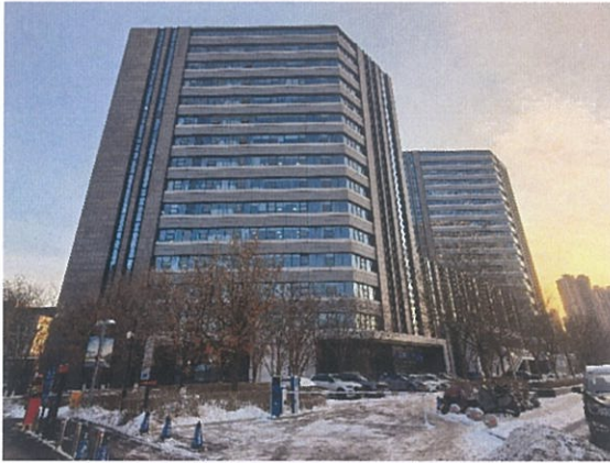
软件园一期 E03 外观
