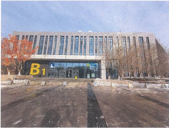
软件园一期 B01 外观
