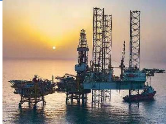
中海油渤中垦利油田群岸电应用工程项目
