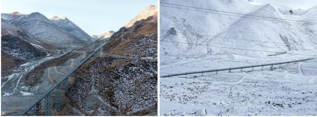
西藏巨龙铜业金属矿第二原矿胶带运输工程带式输送机
