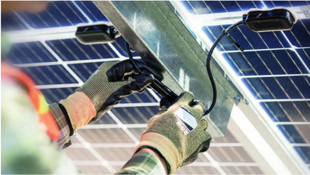
图 3-13 新能源连接器应用于光伏
