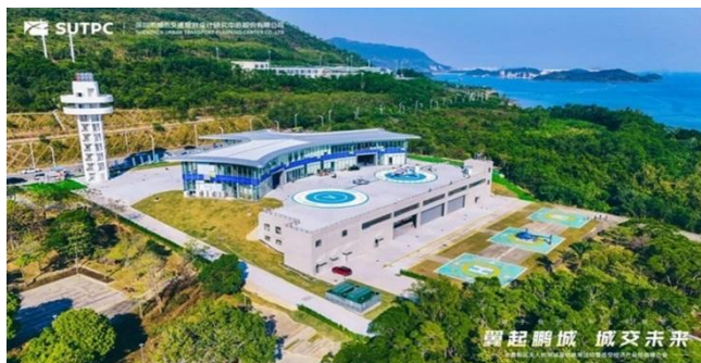
图 24 大鹏新区无人机测试基地及起降点项目
