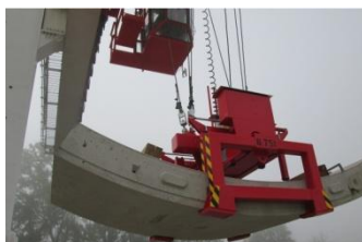
自动化管片吊机
