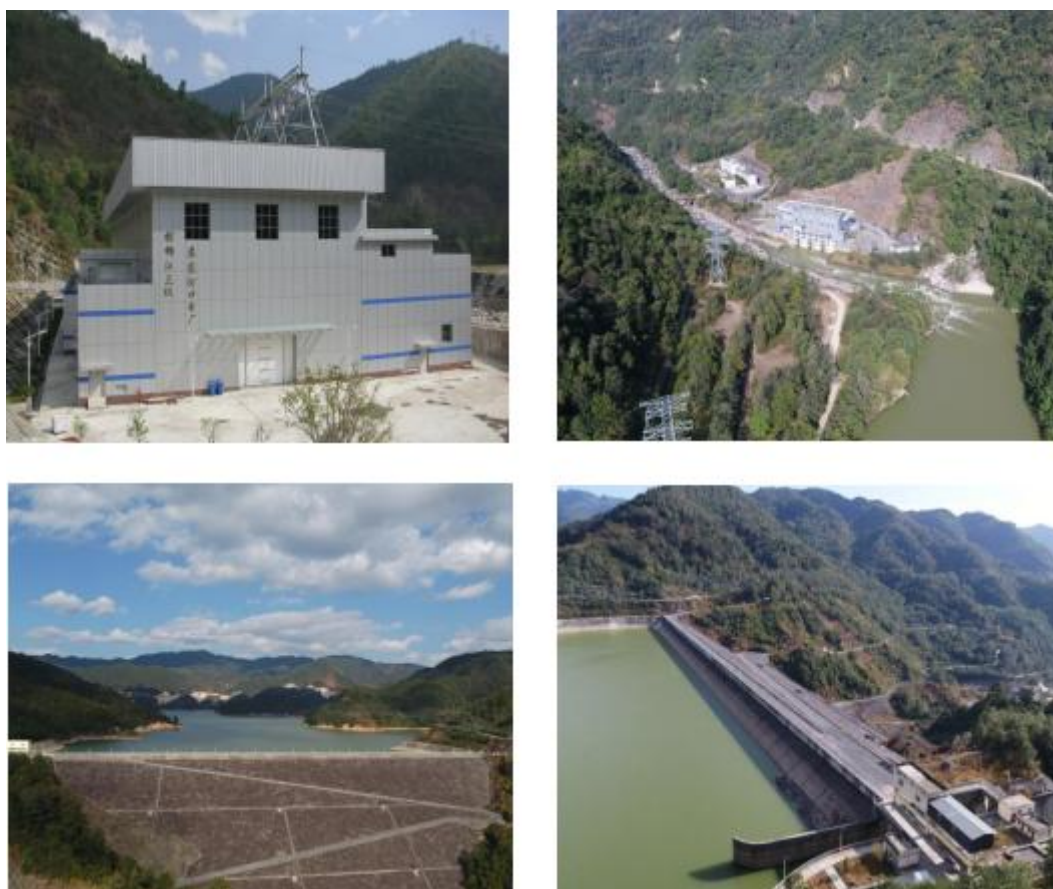
图 2 苏家河口水电站项目厂房及大坝外景图
