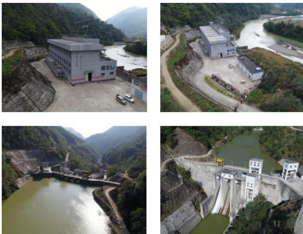
图 3 松山河口水电站项目厂房及大坝外景图
