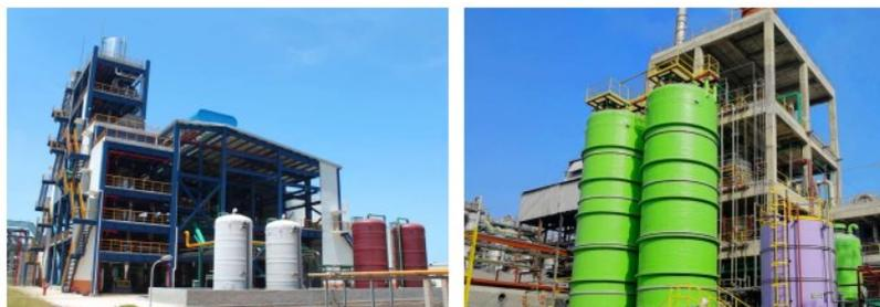
围绕含油污泥“减量化、资源化、无害化”的处置目标，解决现有热解装备热效率低、处理量小、回收油重质化高、产气率低的技术瓶颈，探索“碳减量、碳减排、碳回收”技术路线，报告期内，公司对新型热解系统（OTTU）进行装备工艺优化，结合热解气冷凝净化回收油/气工艺，并建立 COMSOL 能耗预测模型，在保证实现处理后渣土含油率低于 0.3%（农用污泥 B 级标准）的同时，充分优化装备热效率及油泥处理量，为新疆阿克苏油泥处置项目、宁波富含油废弃物无害化处置项目的提产增效提供技术支撑。
