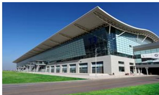
西安咸阳国际机场 T3 航站楼
