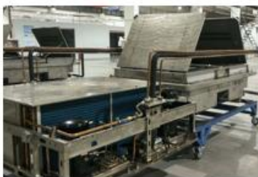
796机组完成试修
