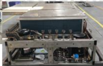
797机组完成试修
