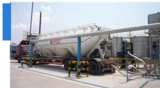
槽车卸料实景图
