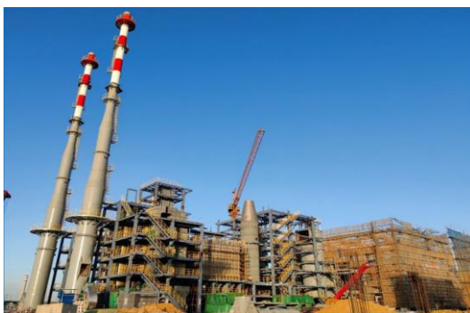
山东裕龙产业园危废焚烧项目
