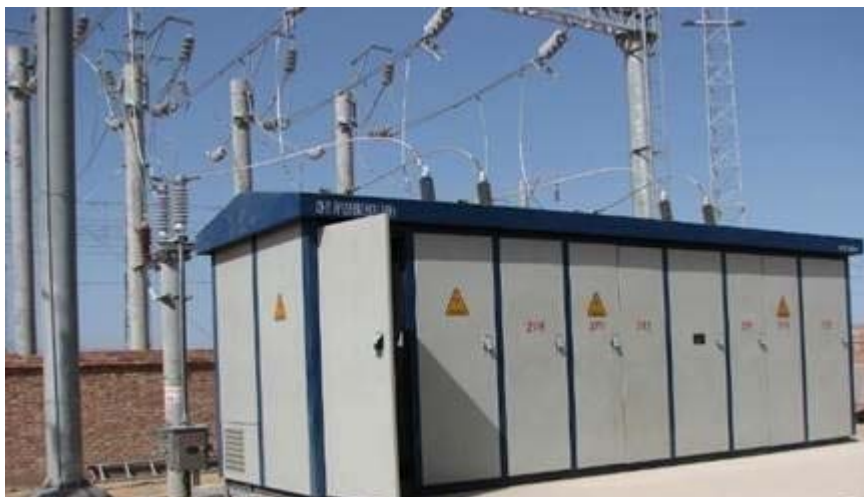
箱式分区所现场照片
