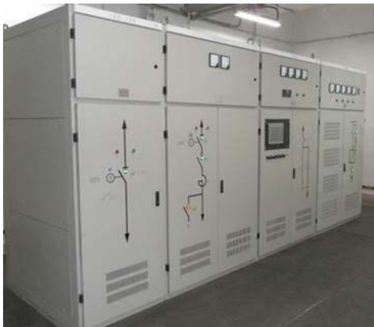
再生制动能量吸收装置
