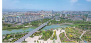
宁夏固原市海绵城市建设 PPP 项目
