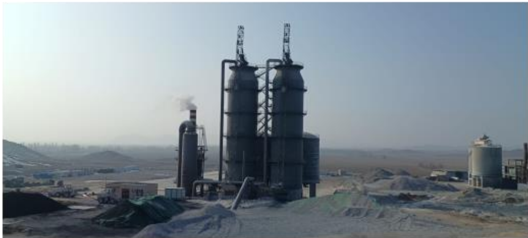
聚鑫钙业 氧化钙（环保竖窑）生产线
