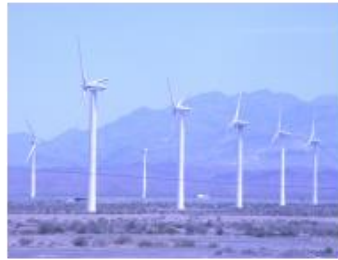
塔城发电 风力发电厂
