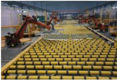
普耀建材 玻璃生产车间
