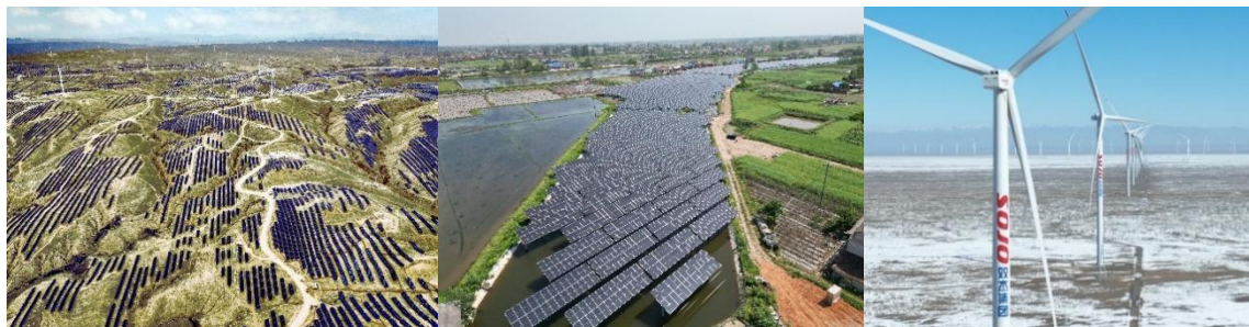
宁夏中卫光伏发电 EPC 工程
