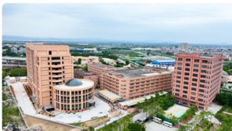
汕头妇产医院&月子中心综合大楼（建设中）
