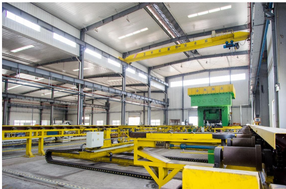
高铁道岔全自动液压机生产线
