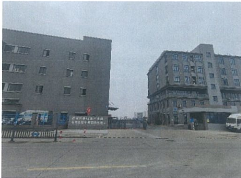
二期西邻嘉兴远景物流产业园
