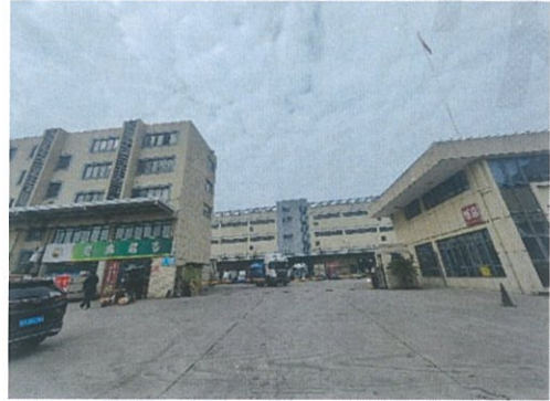
二期南邻工业园区
