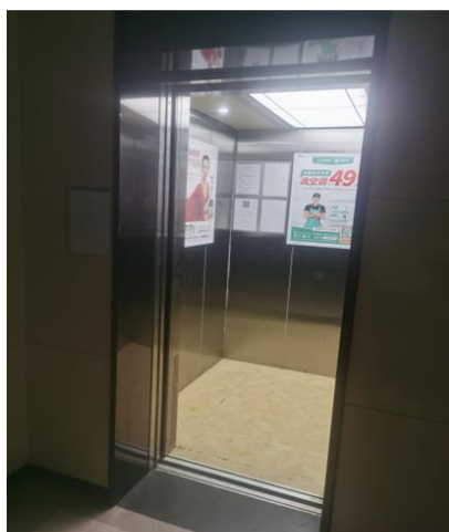
基础设施项目电梯装修
