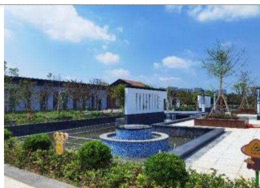
南昌市新建城地下生态水厂（2 万吨/天）
