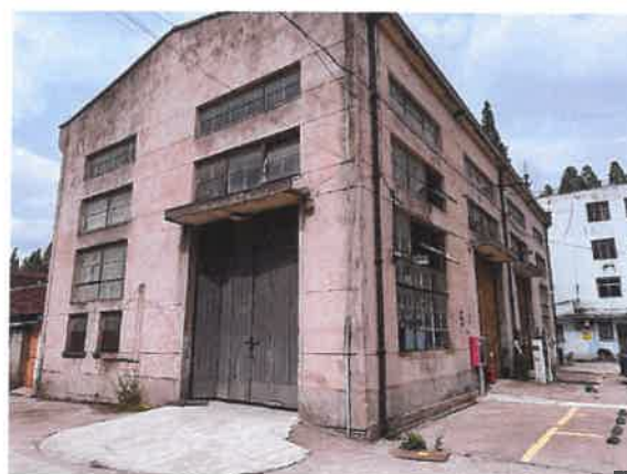
估价对象房屋外观
