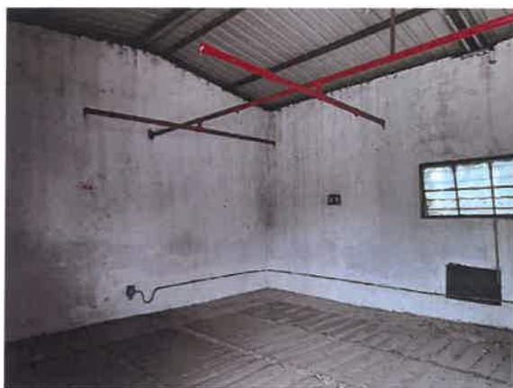
估价对象房屋室内
