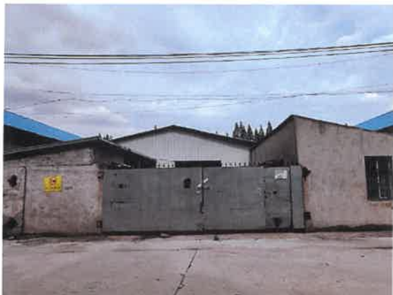
估价对象房屋外观
