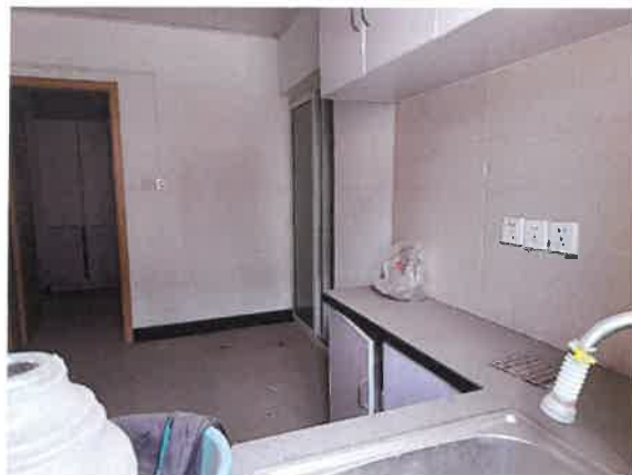
估价对象房屋室内
