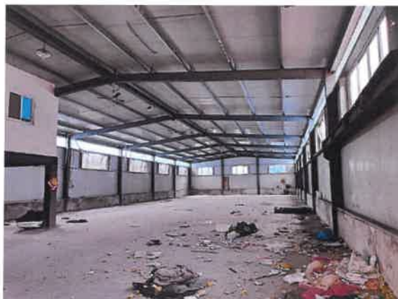
估价对象房屋室内
