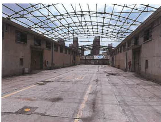
估价对象房屋外观
