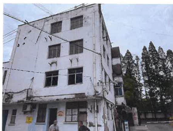
估价对象房屋外观
