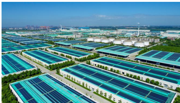
恒力（南通）产业园光伏发电
