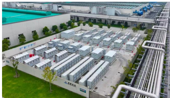
恒力（南通）产业园储能项目
