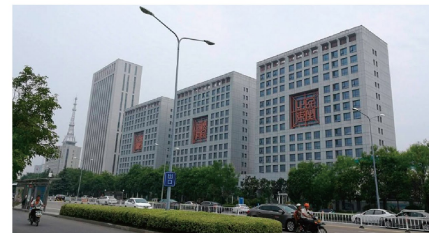
京东云华东数据中心
