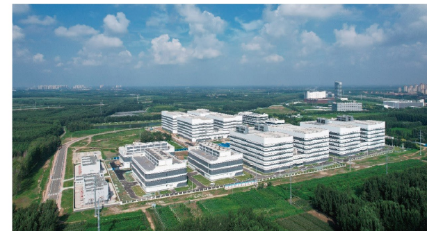
中国电信京津冀大数据中心
