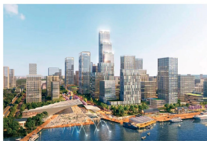
北京城市副中心站综合交通枢纽工程
