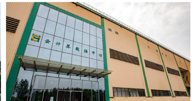
杭钢云计算数据中心
