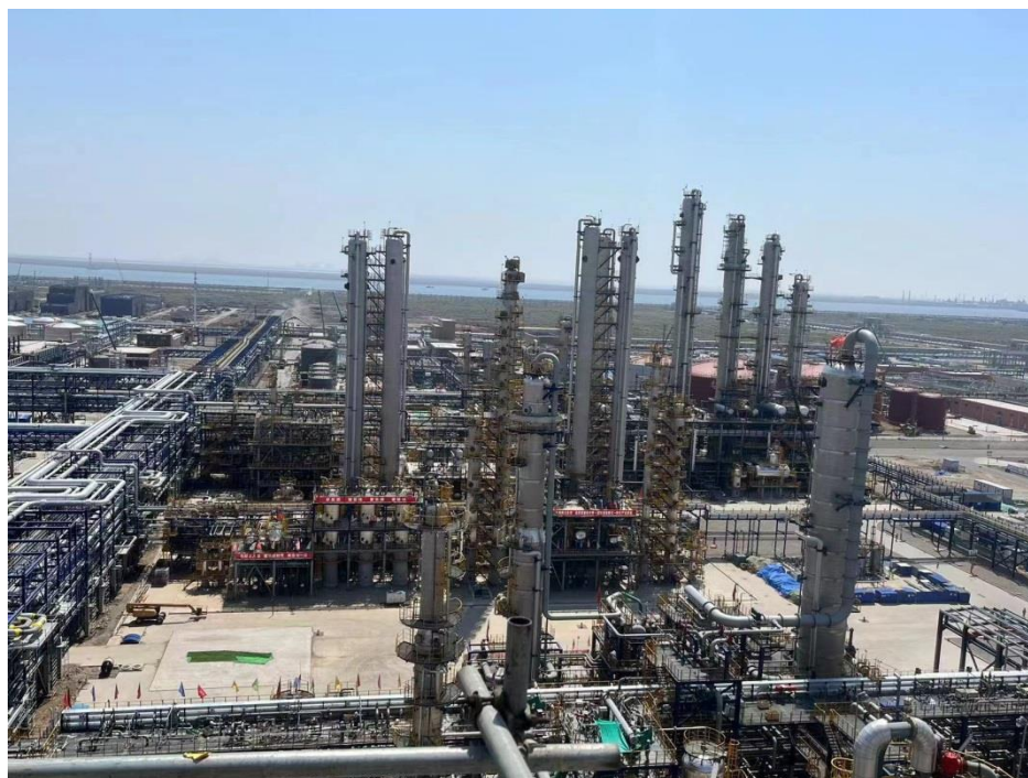
中国石化天津南港 120 万吨/年乙烯及下游高端新材料产业集群项目（EPC）（图）
