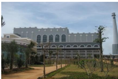
海南海口垃圾焚烧发电厂 处理能力：600 吨/日×4 装机容量：24MW×2
