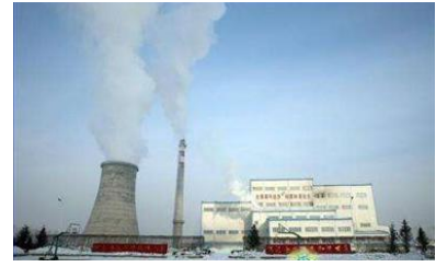
哈尔滨市双琦生活垃圾焚烧发电改扩建项目 处理能力：600吨/日×2 装机容量：12MW×2
