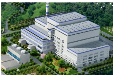
宁德生活垃圾焚烧发电项目 处理能力：300 吨/日×2
