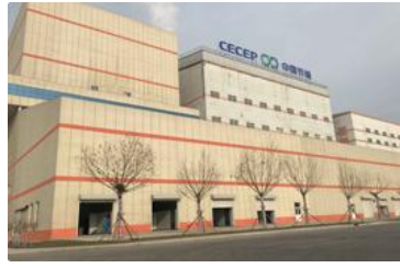
石家庄灵达垃圾转化热电站项目 处理能力：750吨/日×1 装机容量：15MW×1
