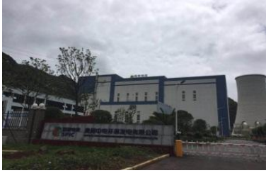
花溪垃圾焚烧发电厂 处理能力：600吨/日×2 装机容量：12MW×2
