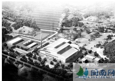
龙岩市生活垃圾焚烧发电厂 处理能力：300 吨/日×2 装机容量：12MW×1
