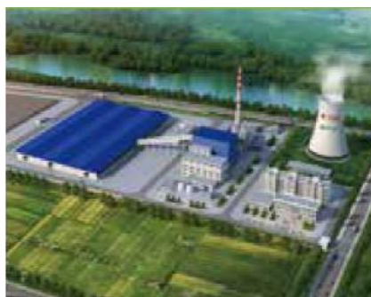
西丰生物质项目 项目规模： 130t/h 锅炉 30MW 机组
