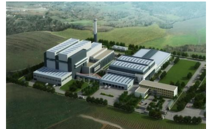
烟台润达垃圾焚烧余热发电厂 处理能力：500 吨/日×2 装机容量：12MW×2
