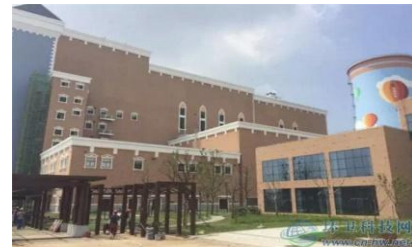
芜湖垃圾焚烧发电厂 处理能力：600 吨/日×2
