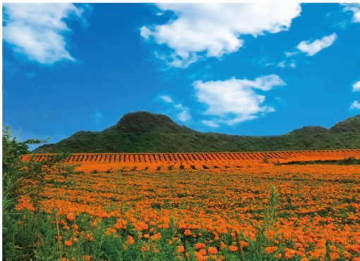
闭库治理后的陡牛坡尾矿库
