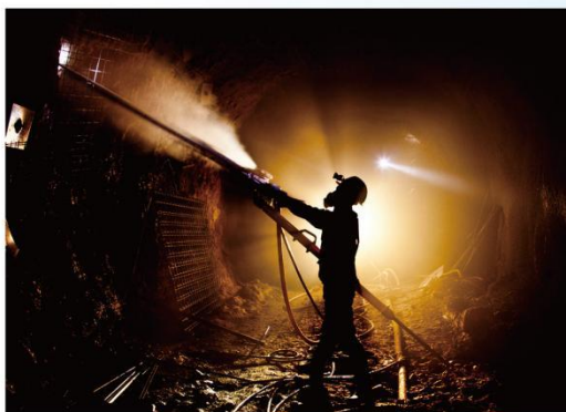
大屯锡矿井下支护
