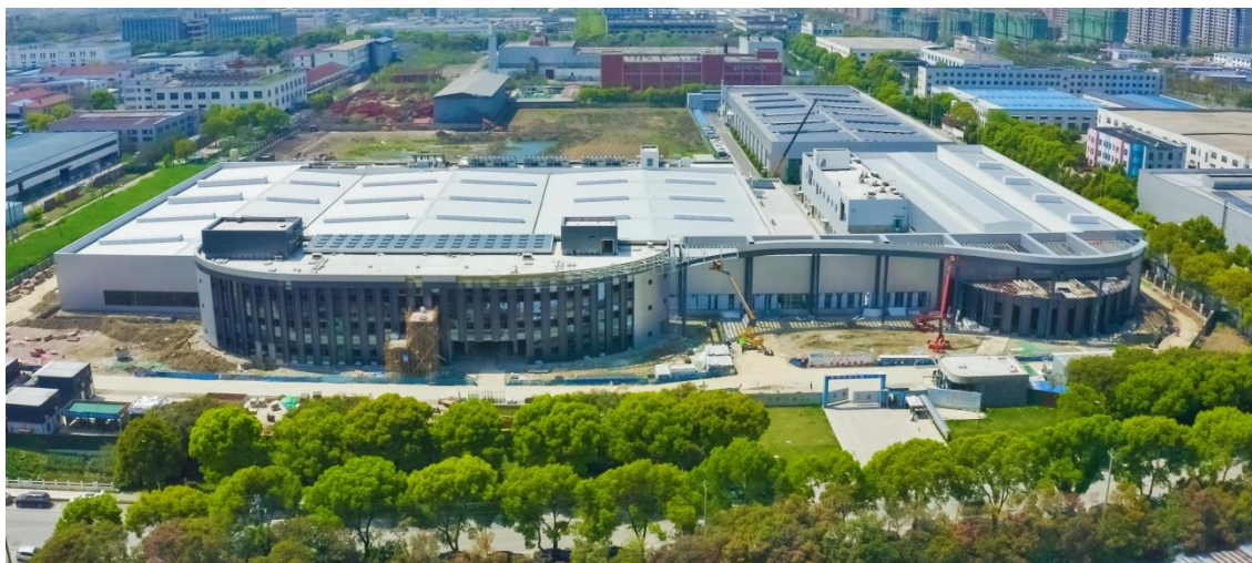
2022 年底无锡三期厂房俯瞰
