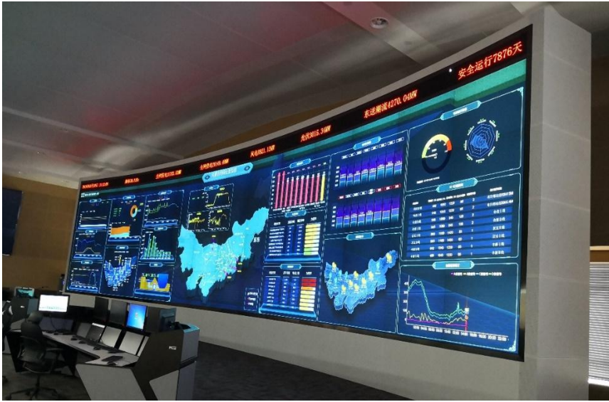
图 6：电力调度指挥中心现场图
