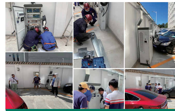
为职工安装充电桩
