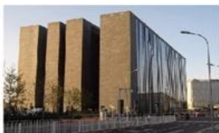
奥运数据中心
