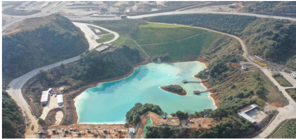
图：杨桃坞酸性水库防渗治理工程现场施工照片
